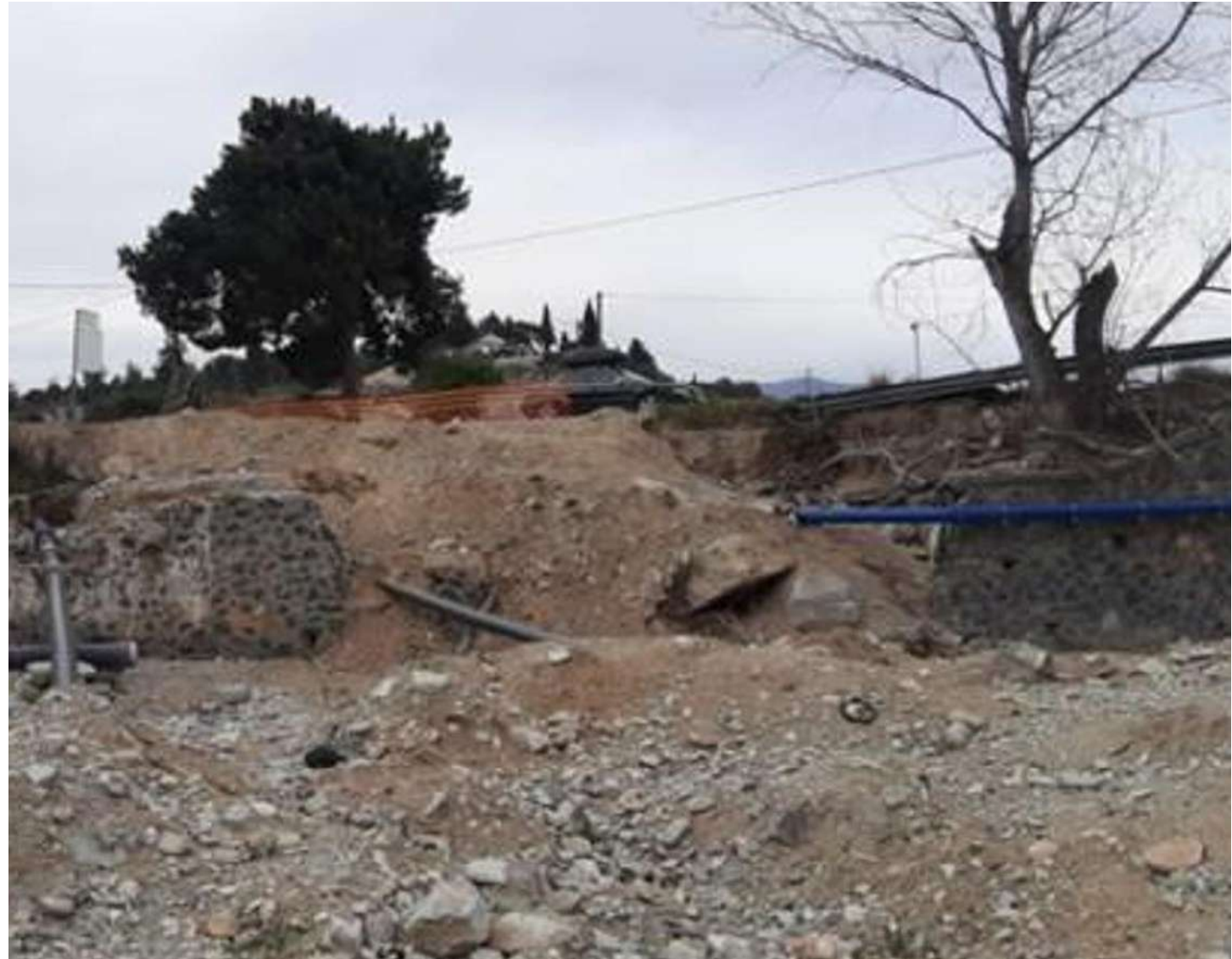
Δήμος Βόλου Γέφυρα στο Αλιγαρόρεμα
