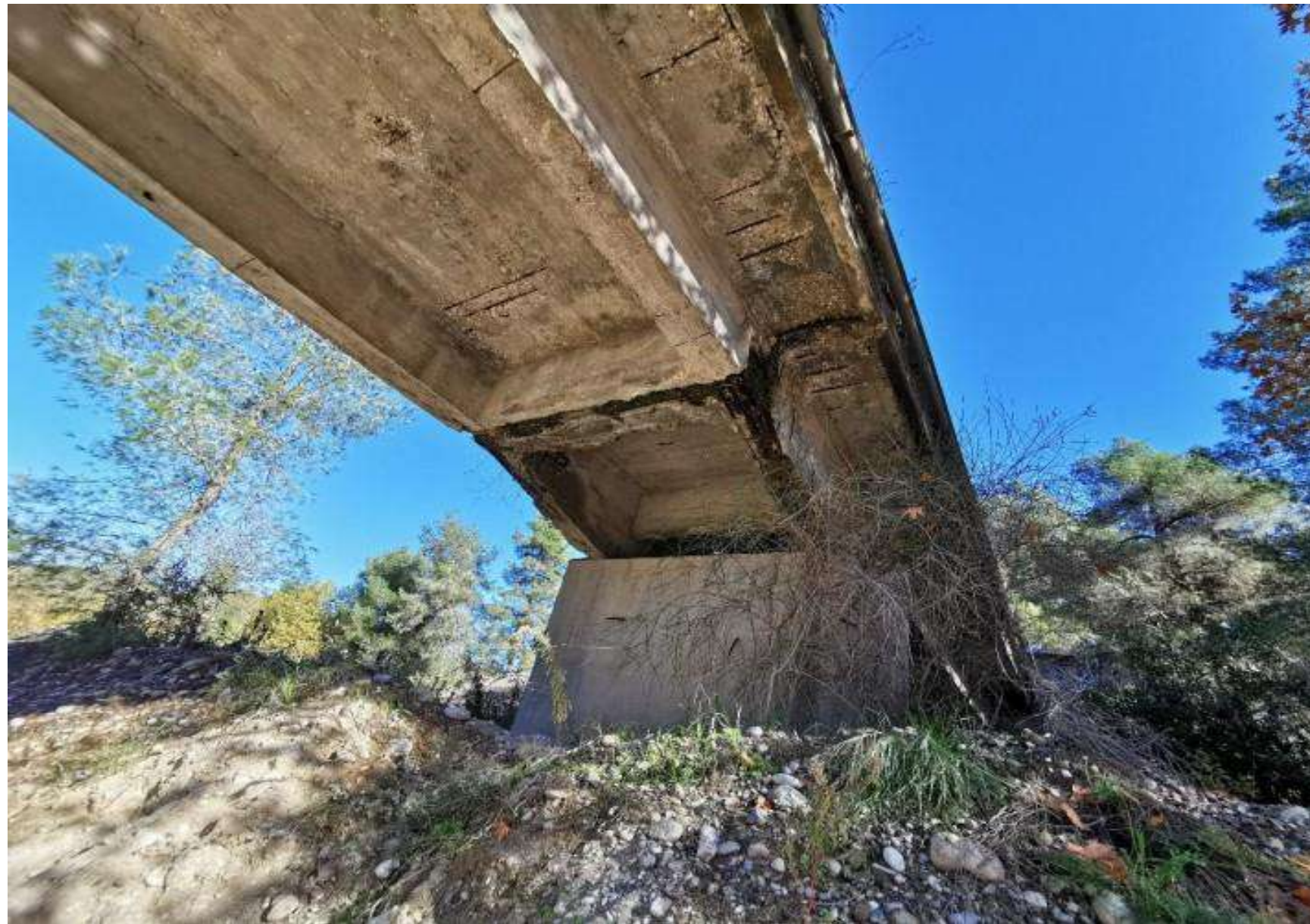
Δήμος Ιστιαίας - Αιδηψού Γέφυρα διάβασης ρέματος της ΕΠ.Ο. 26 Καμάρια-Κρυονερίτης -Μαρούλι δια Μονοκαρμάς
